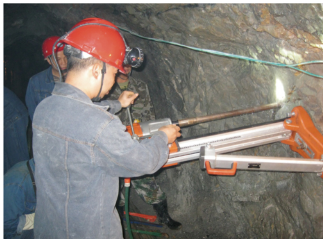
现场钻探作业
