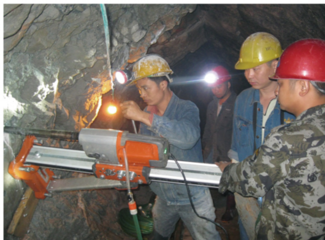
现场钻探作业
