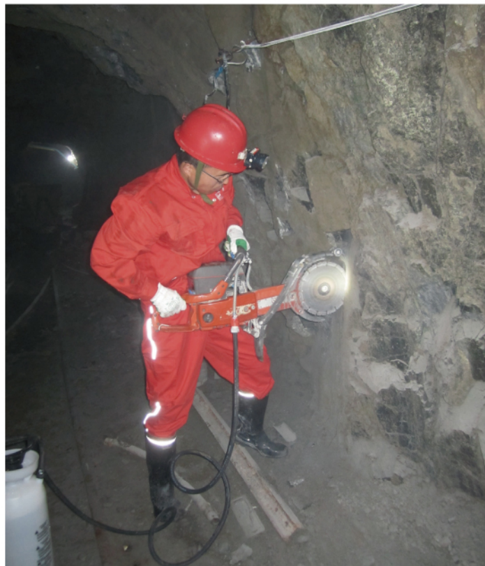
现场刻槽作业
